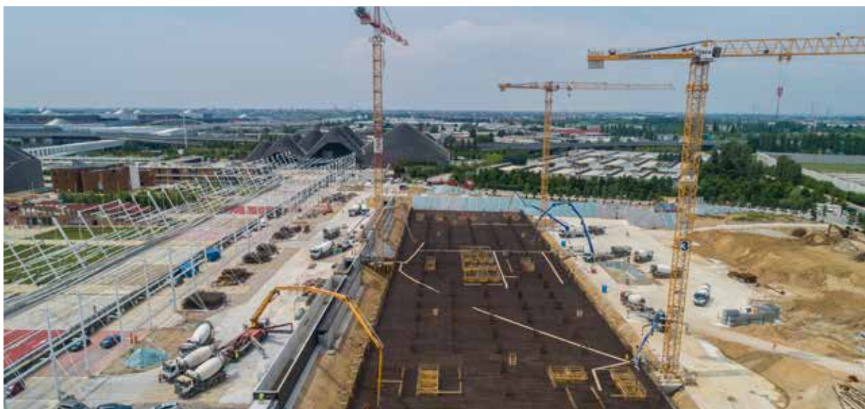
Lavori per la realizzazione della nuova sede dell'Istituto Ortopedico Galeazzi in area Ex-Expo 2015, Milano
